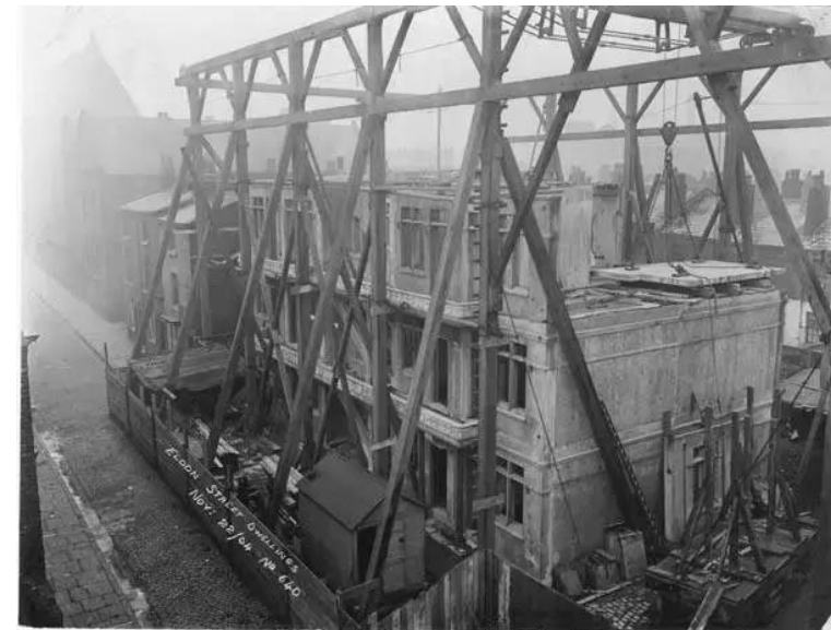
Construção de Eldon street em Liverpool
